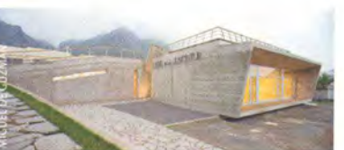
10 LOS SILOS YOUTH CLUB Architects: Lavín arquitectos S.L., Alejandro Lavín Della Ventura, Francisco Miguel Lavín Della Ventura Completed: 2005 Address: Avenida de Aregume, Los Silos
