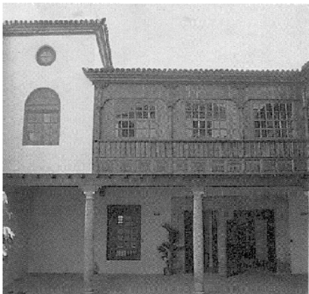
Rehabilitación Casa Lercaro. Saavedra y Abreu.
